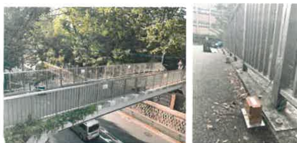
図-5 無線加速度計設置状況
