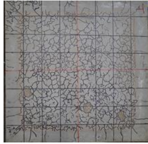
図-4 加熱面の損傷状況 (LH)
