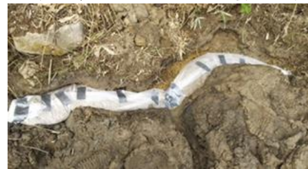
図-7 T字型の導水ホースの様子
