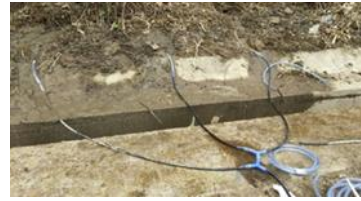
図-5 導水装置設置の様子
