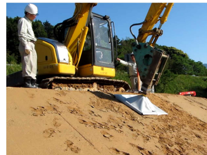
図 5 振動締固めによる法面施工状況
